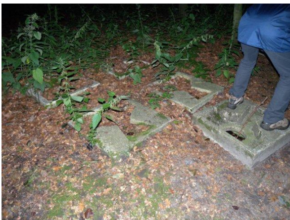
de restanten van toiletten uit de laatste wereldoorlog vroegen om een demonstratie
